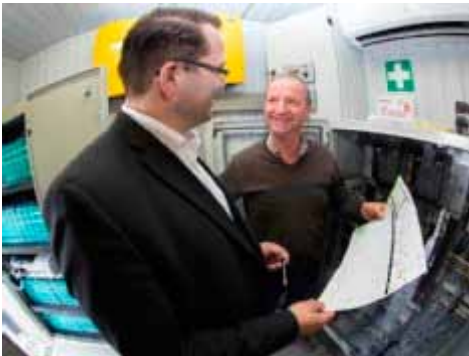
Mathias Zdzieblowski (l.) von der Tesvolt GmbH und Bernd Gempel von Hanni-Solar freuen sich über das gemeinsame Projekt.
